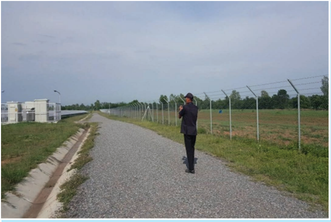
การรักษาความปลอดภัยบริเวณโครงการ
