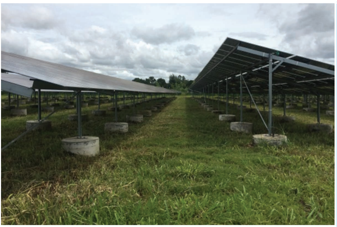
ดูแลรักษาความสะอาดใต้แผงเซลล์แสงอาทิตย์
